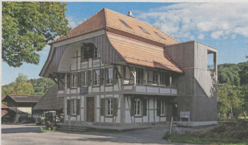
Aussenansicht nach dem Umbau: der typische Charakter des Rieghauses mit Rundbogen ist unverändert erhalten.
