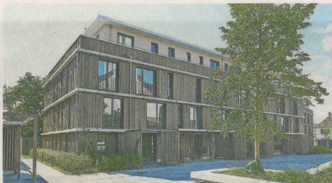
Holzfassaden unterstützen die spielerisch leichte Architektur.
