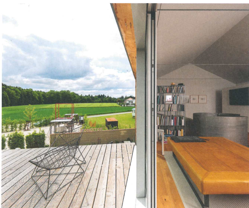
Links die Dachterrasse mit Ausblick, rechts das Satteldach mit Zugbändern aus Stahl. Der Bauherr wünschte sich einen Dachraum ohne Balken. Urs Weber lieferte eine unterspannte Dachelementkonstruktion ohne Firstabstützung, die nur durch die stählernen Zugseile zusammengehalten wird.
