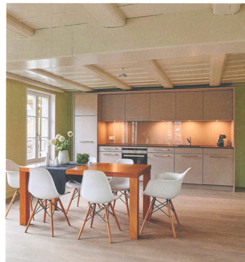
Offene Räume gibt es auch im Obergeschoss. Das originale Täfer wurde nach der Dämmung der Aussenwände wieder montiert und erhielt eine neue Farbe.
