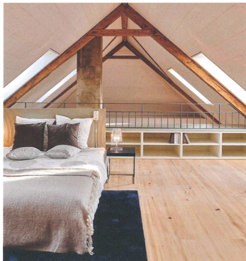
Im ehemaligen Speicher bietet ein Zwischenboden zusätzlichen Wohnraum, belichtet durch neue Dachfenster. Die Konstruktion blieb erhalten, wurde aufisoliert und neu eingedeckt.
